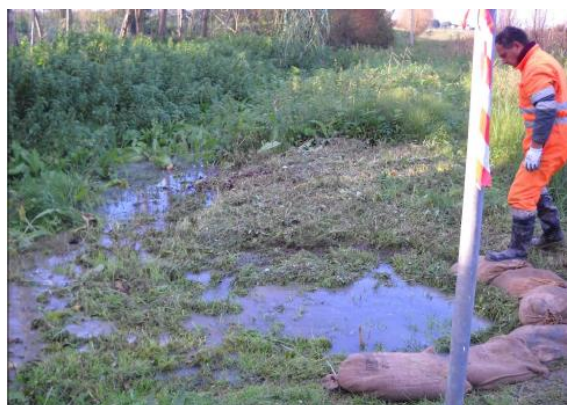
Figura 3.3 Evento di piena 2019: fenomeni filtrazione e fontanazzi presso il centro di Mazzorno Sin. e loc. Casa Borella (Erbacci et al., 2022)
