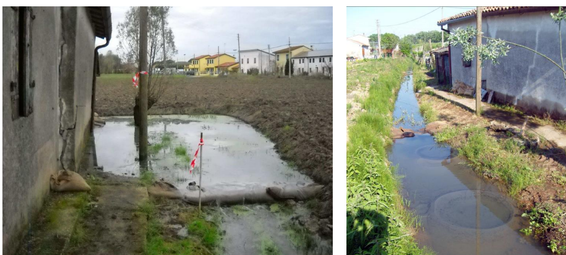
Figura 3.2 Evento di piena 2019: fontanazzi e fenomeni filtrazione presso Mazzorno Sin., autorimessa Orlandi (Erbacci et al. 2022)
